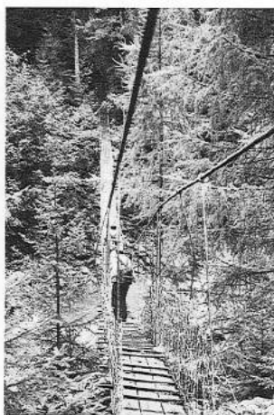
Holzbrücke über den Inn
